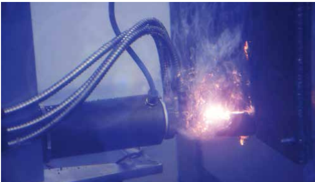
Das Laserschneiden unter Wasser bietet enormes Potential für den Rückbau von Reaktorbehältern. (Foto: LZH)
